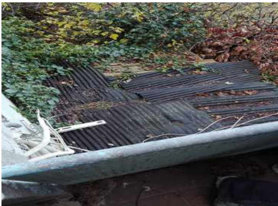
Foto tettoia Piano Terra (si vede dall'alto la copertura con fogli di lamiera)
