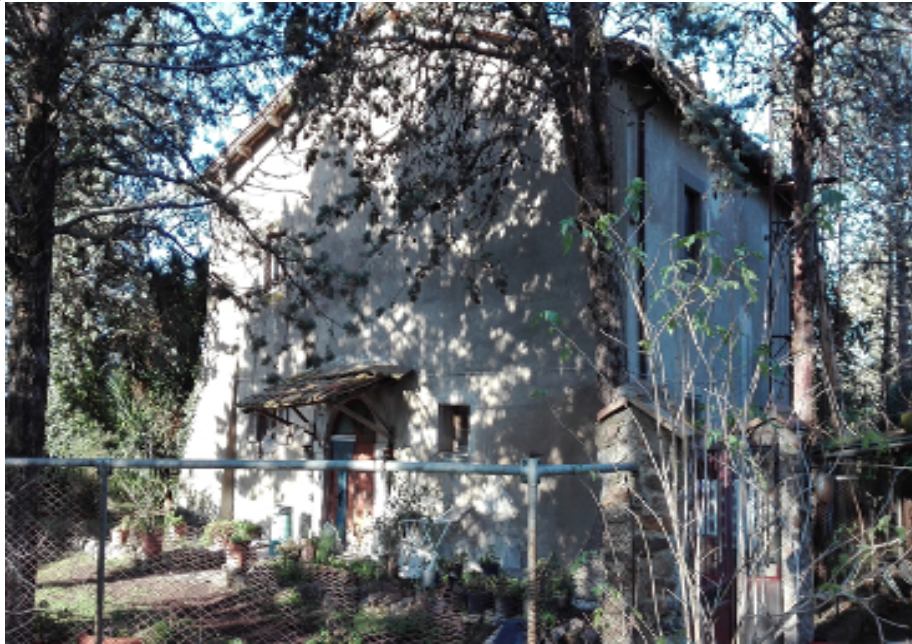
Foto interne – piano terra
